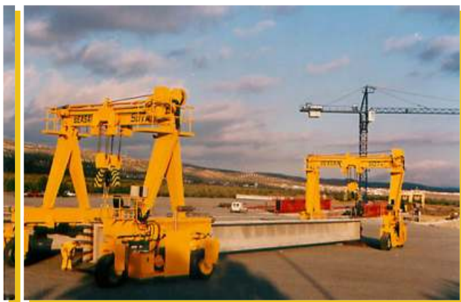
ПЕРЕМЕЩЕНИЕ БЕТОННЫХ ЗАГОТОВОК
