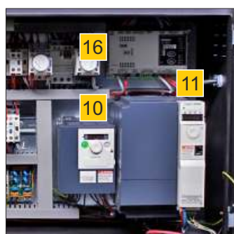
17 Armário elétrico do diferencial
