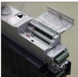
11 Variador na elevação
