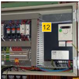
9 Armário elétrico da ponte
