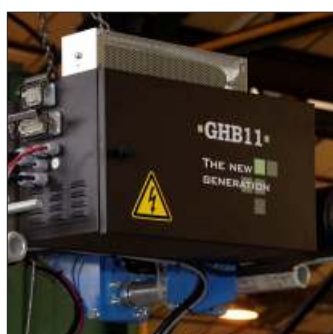
17 Armário elétrico do diferencial
