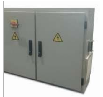
9 Armário elétrico da ponte
