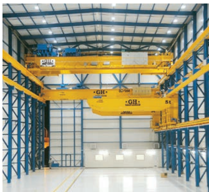
Grúa apoyada birraíl y grúa ménsula
